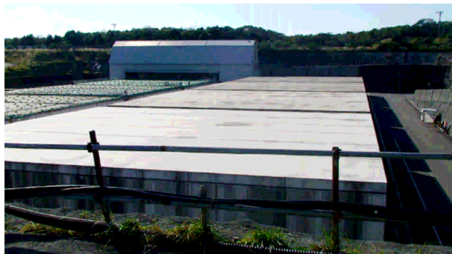
日本六所村放射性 廢棄物處置場
