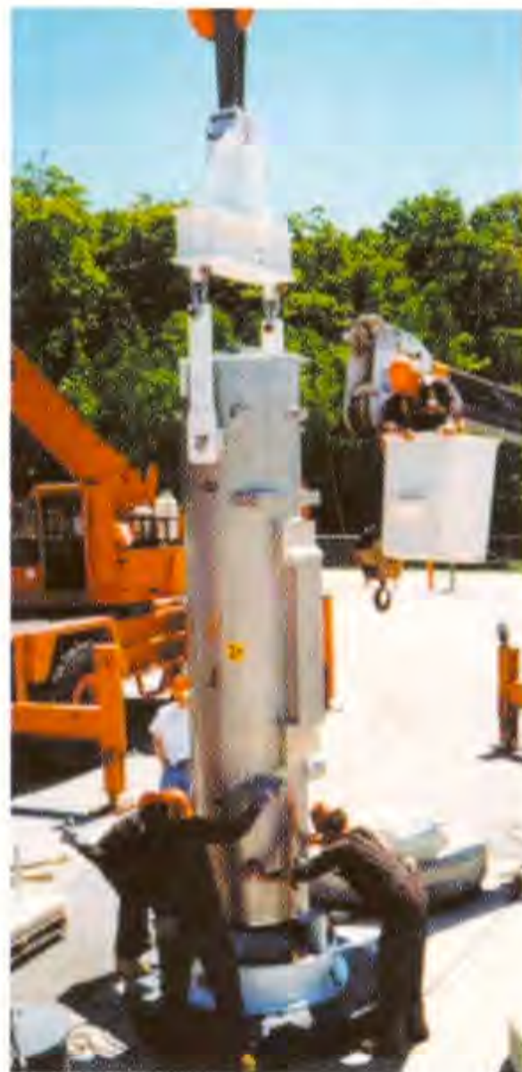
圖3.安大略電力公司工作人員小心地將中放射性廢棄物放進地面下的貯存容器中
