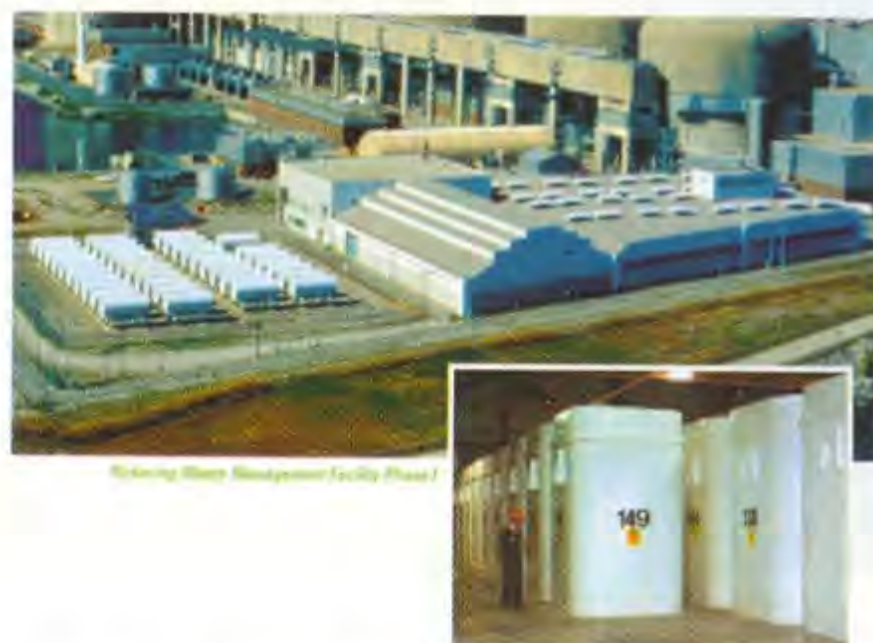
圖2.皮克靈核能電廠一期廢棄物營運設施
