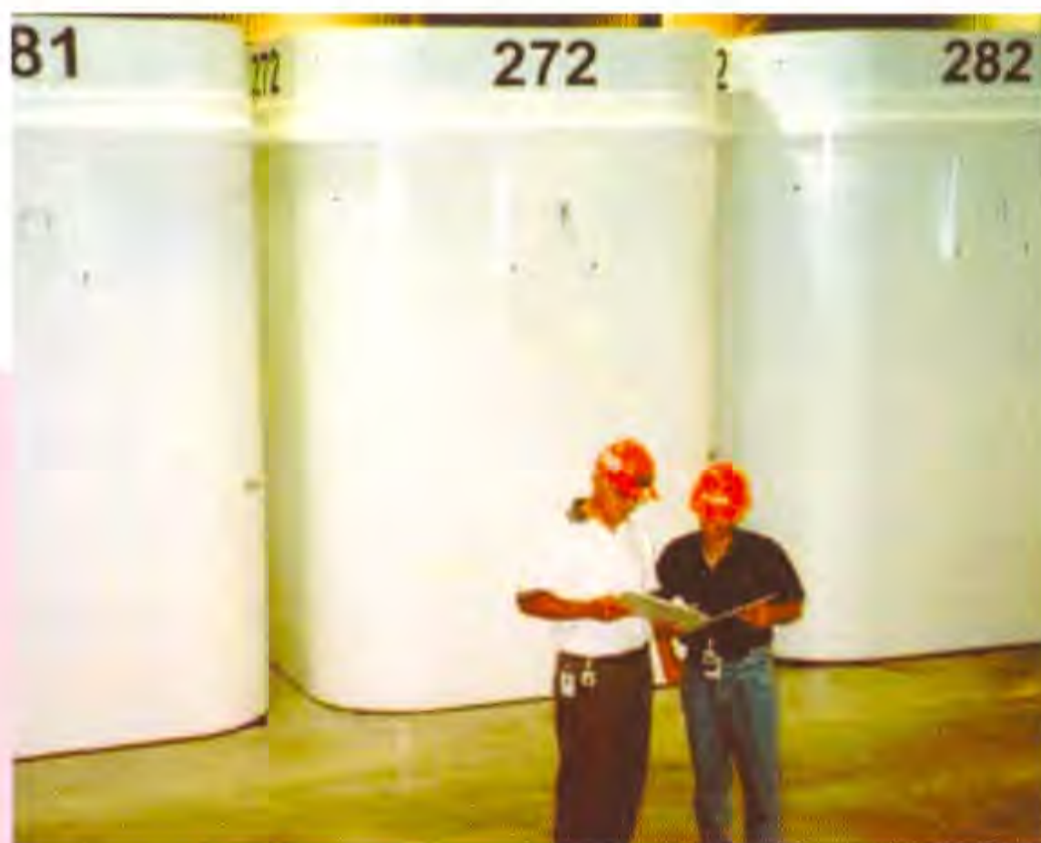
圖4.乾式中期貯存桶在密封、上漆、安裝好國際原子能總署的保全封條之後，便可移入貯存建築。
