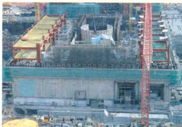
圖2. 2號機反應器廠房施工現況圖景
