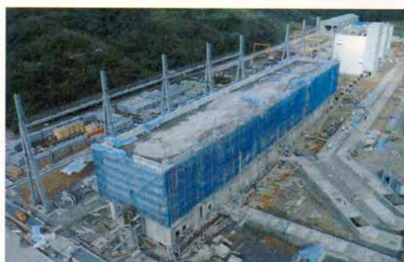
圖4. 開關場施工現況圖景
