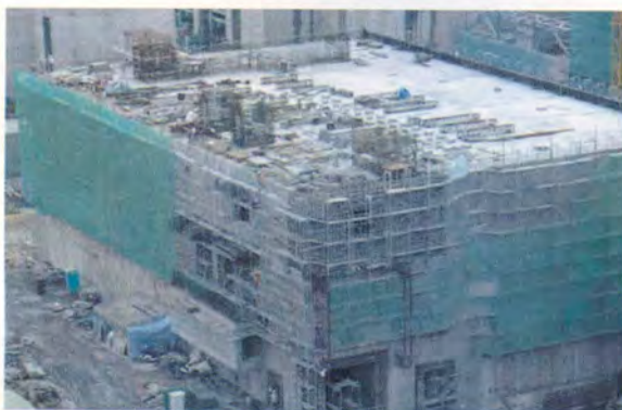
圖3. 輔助用過燃料廠房施工現況圖景
