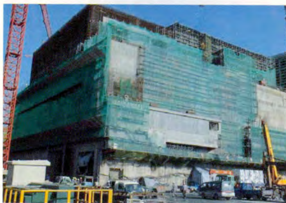
圖1. 1號機反應器廠房施工現況圖景
