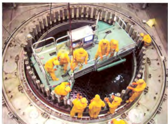
圖1. 核二廠汽水分離器大修情形
