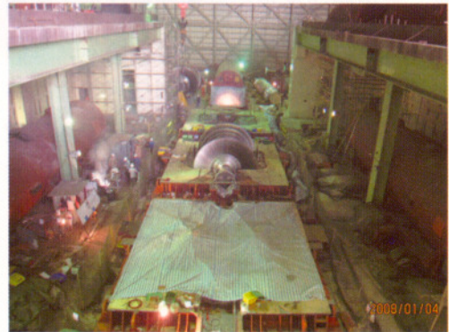
圖3.核四廠汽輪發電機安裝的情形
