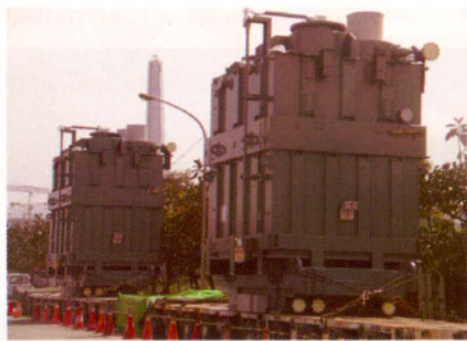
圖4.1號機主變壓器運抵核四工地
