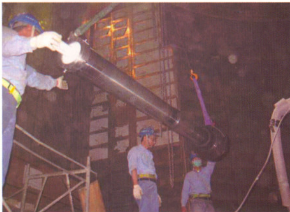
圖1. 1號機爐內泵葉輪安裝作業
