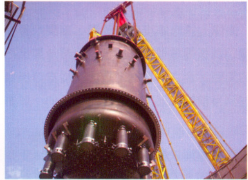
圖2.核四廠反應器壓力槽的吊裝
