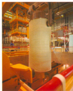
圖2. 洛普廠接收與貯存設施內的excello6號容器被吊起
