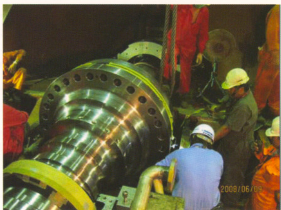
圖2. 1號機汽機連接軸安裝作業
