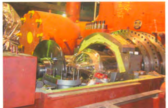
圖2. 1號機汽機主油泵浦調整作業
