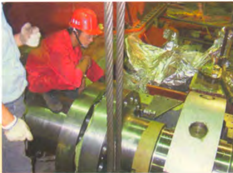
圖1. 1號機汽機對心調整作業
