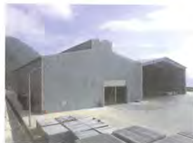
圖4.鋼構廠房：供完成檢整的廢棄物桶暫放及有灌注固化劑者養生用，等壕溝完成檢查及必要的補強後，再移回壕溝貯存。
