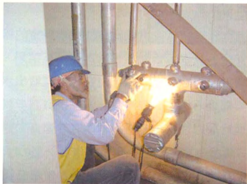
圖1 核四廠1號機下乾井洩水管路銲接作業
