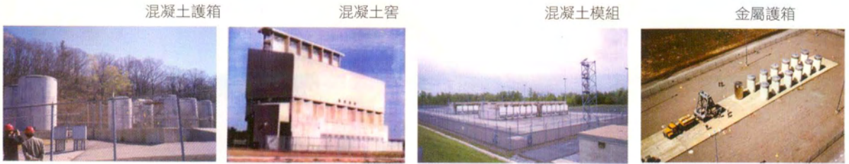
圖8：用過核子燃料乾式貯存設施型式
