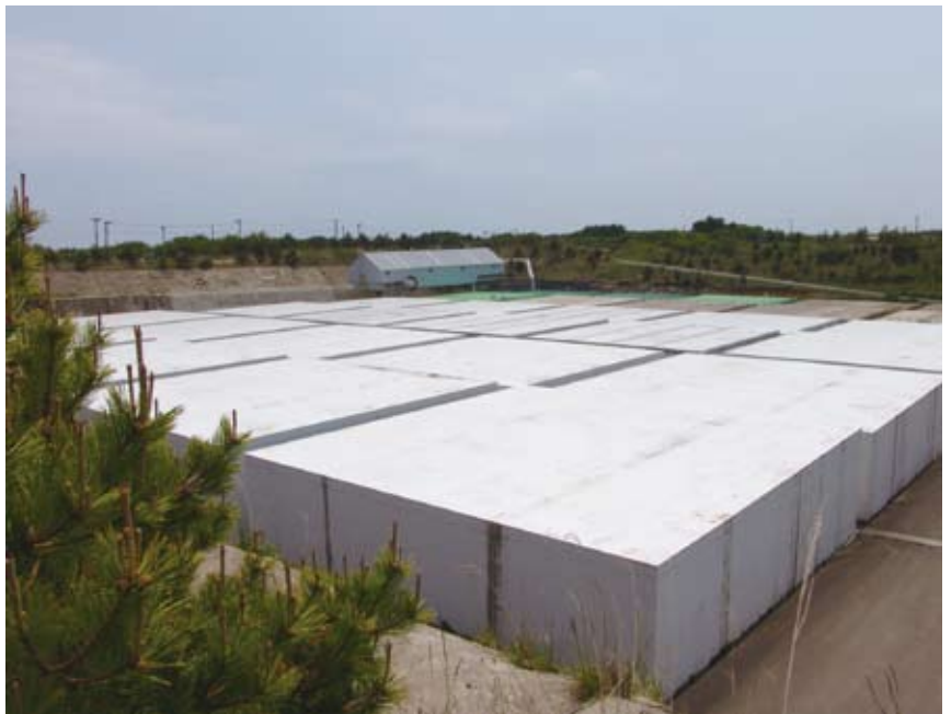
▲ 六所村低放射性廢棄物最終處置場現況
