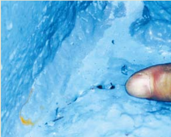
▲ 起動變壓器銹蝕孔近照
