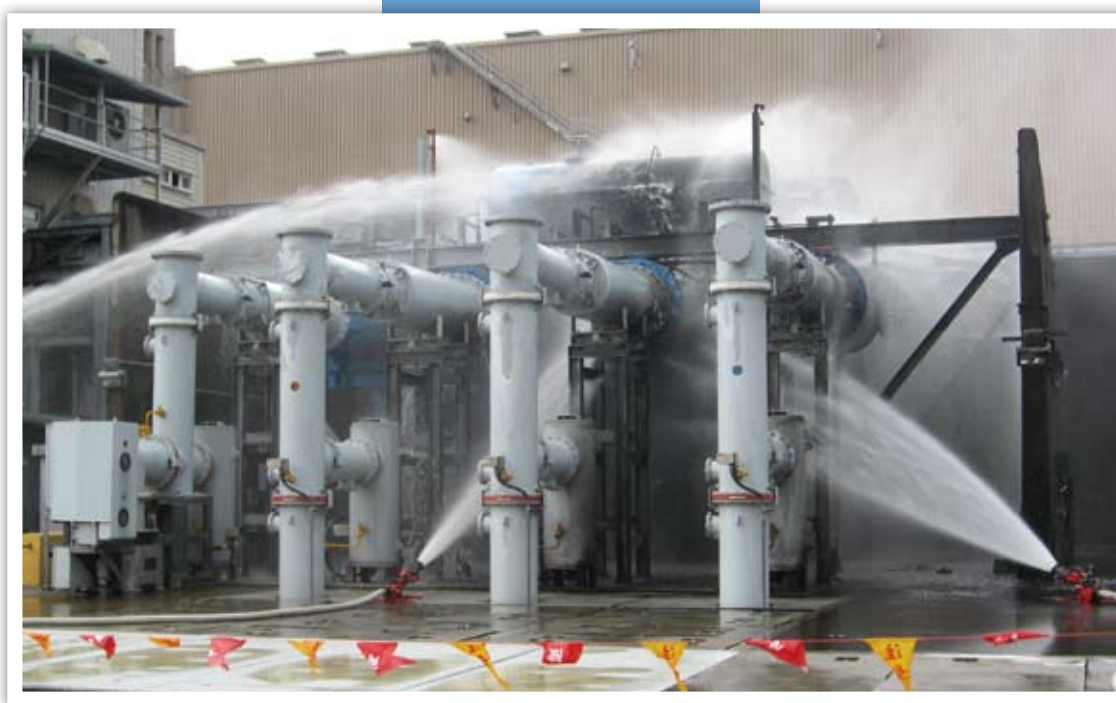
▲ 起動變壓器火災搶救現場
