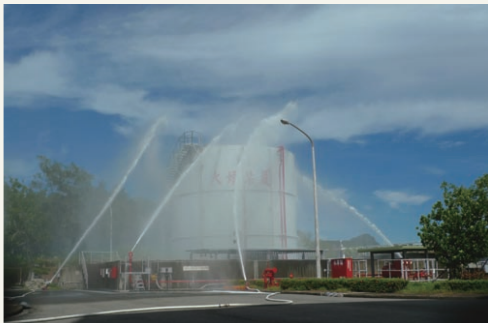
▲ 模擬核三廠油槽火災，廠內消防人員出動自動擺頭式灑水頭，避免高溫危險
