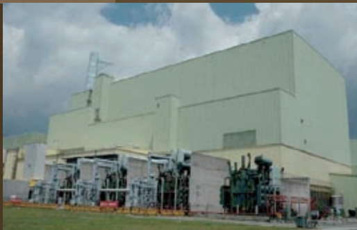
圖1. 龍門電廠1號機汽機廠房現況
