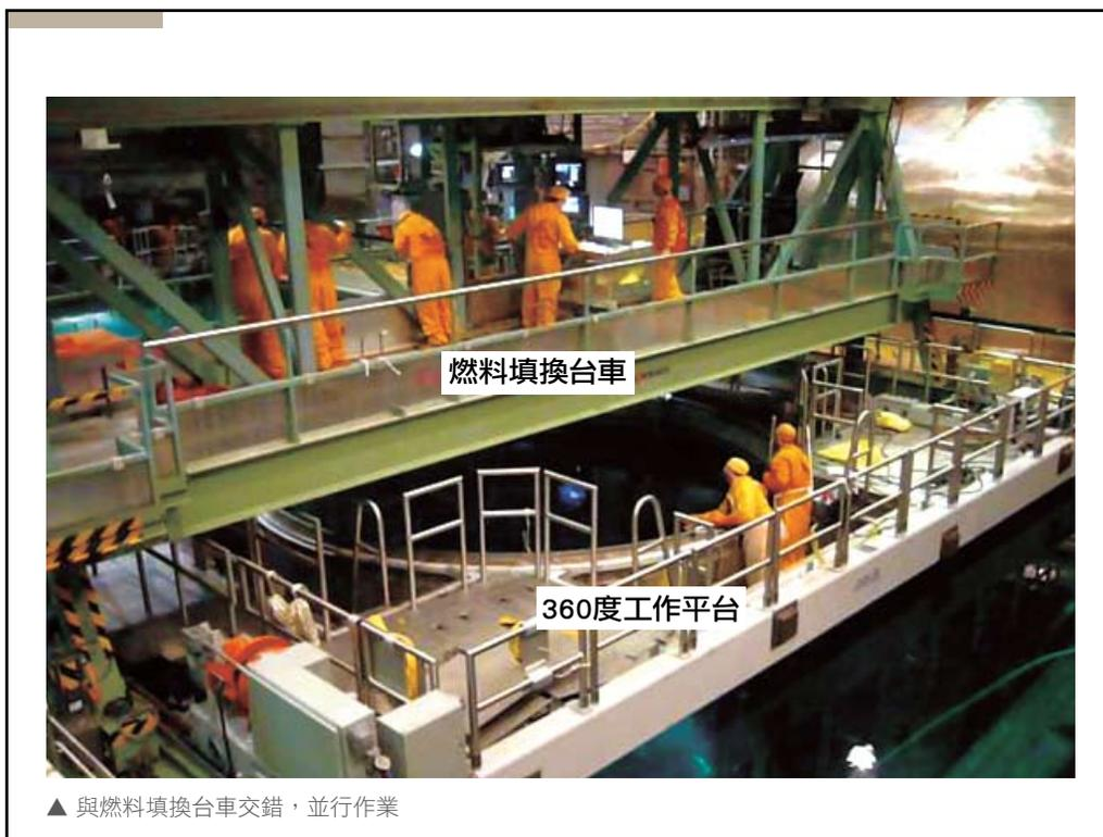
▲ 與燃料填換台車交錯，並行作業
