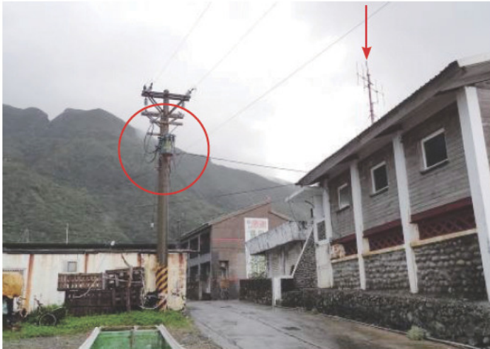
▲朗島舊衛生室後方計有2支附變壓器的電線桿及1具電波發射台，造成電子干擾，誤信號使輻射劑量率因而偏高
