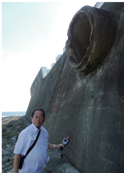
▲朱鐵吉董事長至蘭嶼貯存場外排水溝偵測輻射，確認無超標情形
