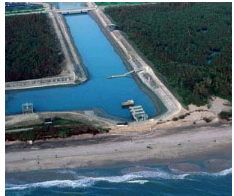
圖 4 St. Lucie 核電廠獨特的進水口
