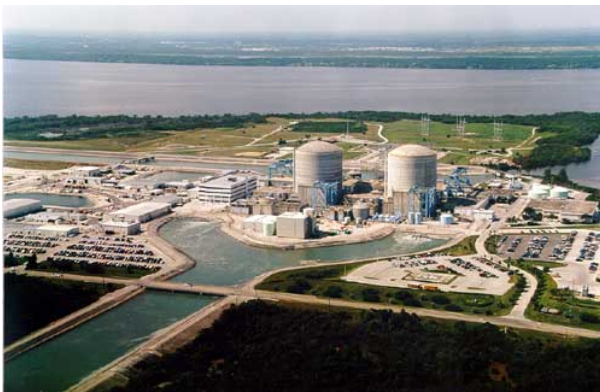
圖 3 St. Lucie 核電廠的露天汽機
