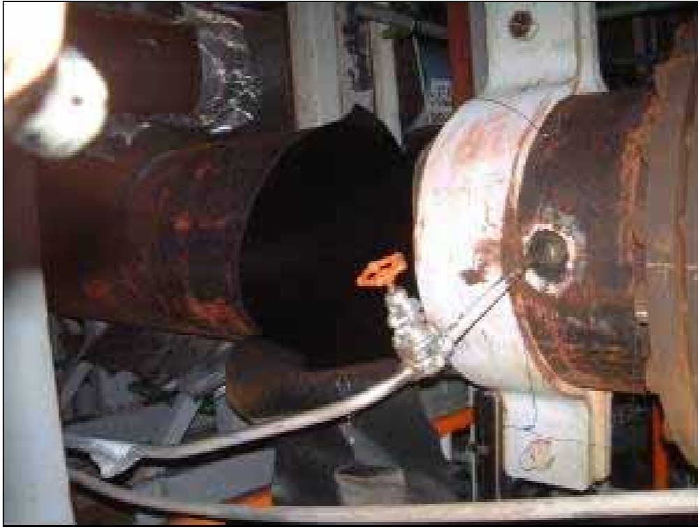
圖 5 美濱之管路破斷處
