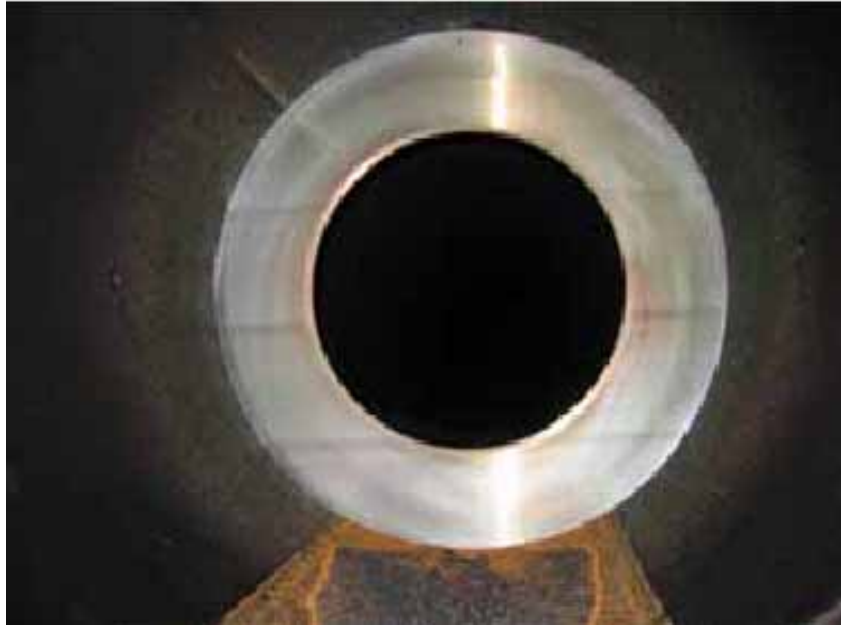
圖 3 破斷處上游之限流孔，前方為破斷處管路內面
