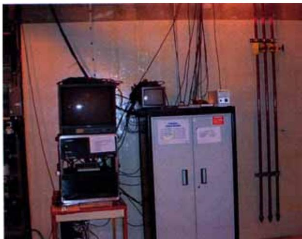
照片 2 費米核電廠遠距監測系統
