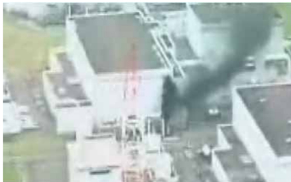
照片 1 3 號機變壓器火災空中攝影
