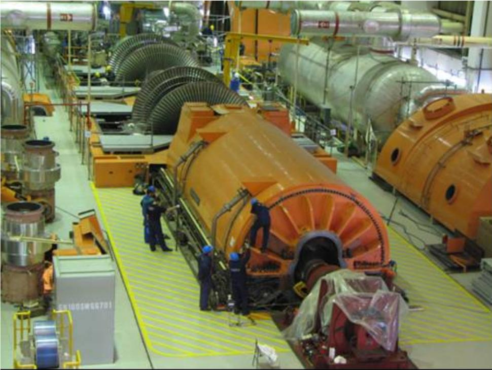
照片 3 更換為三菱低壓汽機提升出力 ( Krsko 核電廠 )
