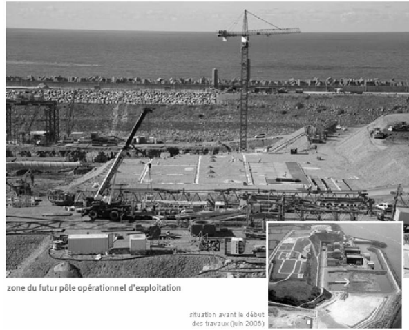
照片 2 Flamanville 3號機反應爐基礎工程
