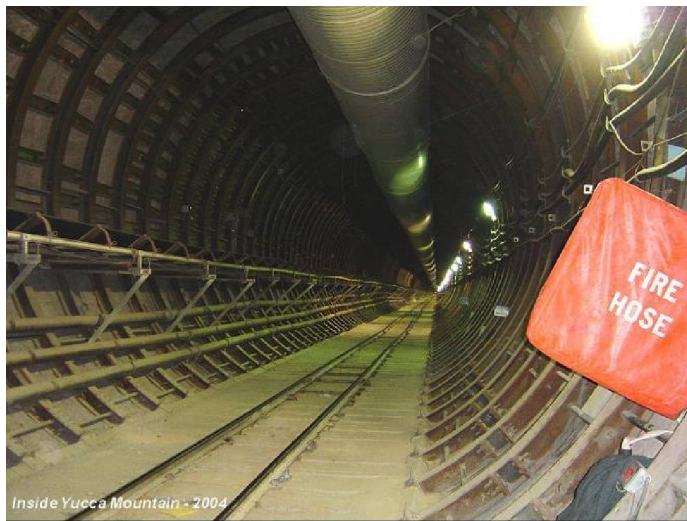
照片 2 隧道內部
