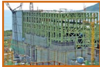
↑ 核能四廠一號機汽機廠房施工現況圖景
