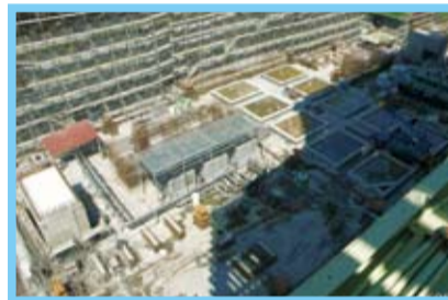
↑ 核能四廠一號機控制廠房施工現況圖景
