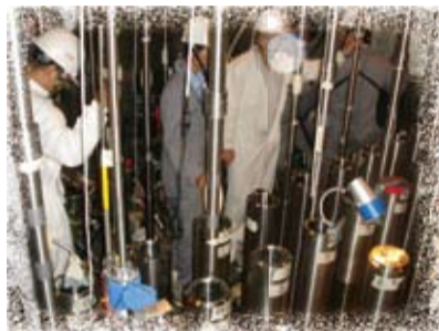
核能四廠一號機反應爐內控制棒驅動殼焊接現場一角
