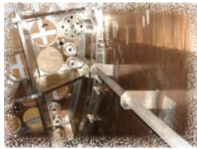
核能四廠一號機反應爐內部從爐底上看爐心底貌
