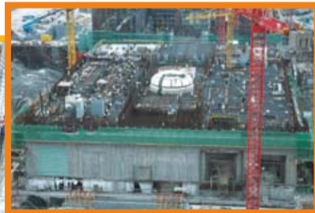
核能四廠二號機反應器廠房施工現況圖景
