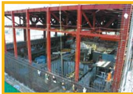
核能四廠一號機反應器廠房施工現況圖景
