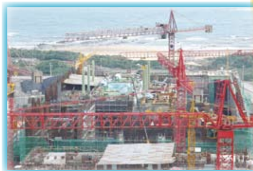
核能四廠二號機汽機廠房施工現況圖景
