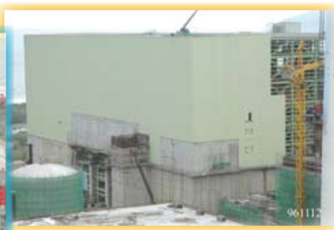
核能四廠一號機汽機廠房施工現況圖景
