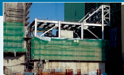
核能四廠一號機控制廠房施工現況圖景
