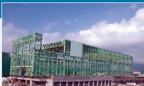
核能四廠抽水機廠房施工現況圖景
