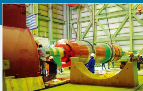
1號機發電機轉子吊裝作業
