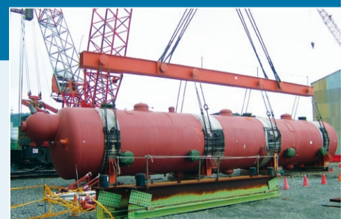
2號機汽水分離再熱器吊裝準備作業
