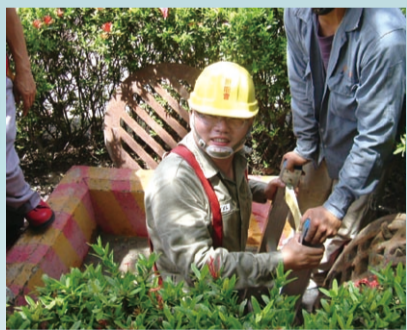
下人孔內查驗地下電纜狀況
