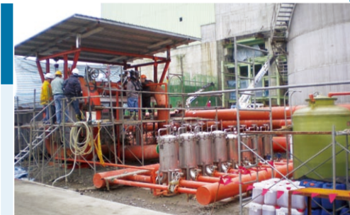
核能四廠1號機管路沖洗作業工作站現況
