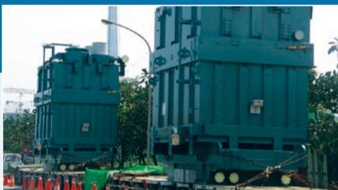
核能四廠1號機主變壓器運抵核四工地
