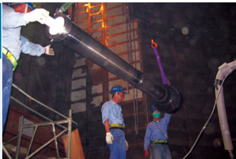
1號機爐內泵葉輪安裝作業
