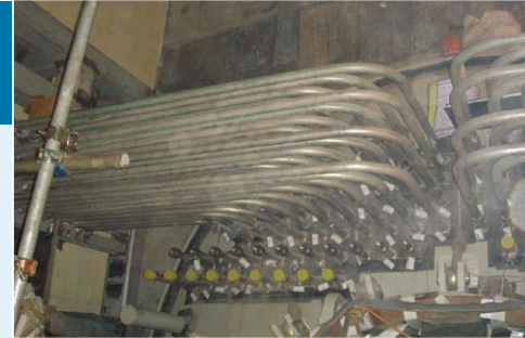
✦ 1號機控制棒急停管路安裝作業
