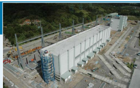
核能四廠電力開關場
