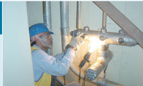
核能四廠1號機下乾井洩水管路銲接作業
