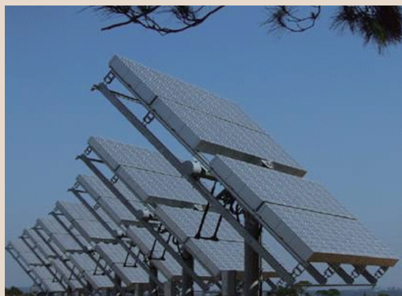
✧ 立柱式5 kW HCPV系統
