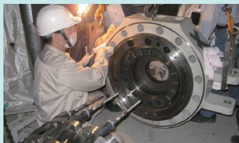
*1號機爐內泵分解檢查作業
