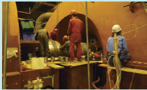
✧ 發電機及汽機轉子齒輪間隔環安裝
