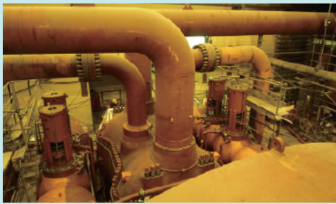
✧ 高壓汽機整體安裝
