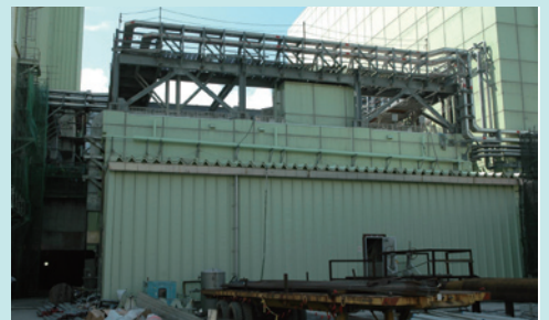
龍門核電廠1號機控制廠房施工現況
