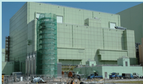
龍門核電廠1號機反應器廠房施工現況
