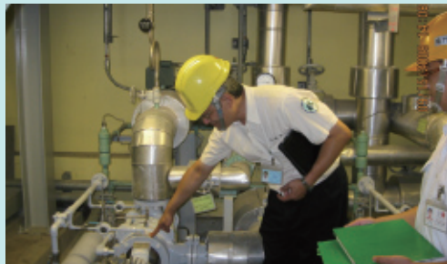
龍門計畫第36次定期視察作業情形
