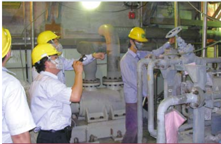
▲龍門計畫第39次定期視察作業情形
