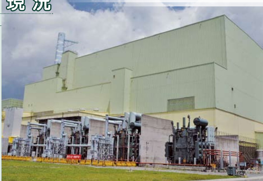
龍門電廠一號機汽機廠房現況
